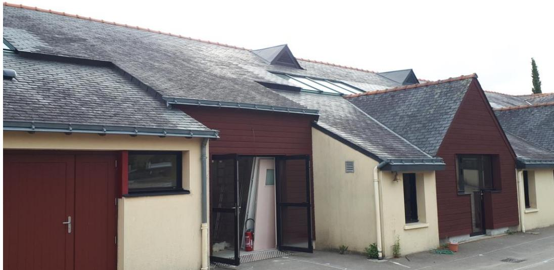
Après: diminution des verrières toiture, remplissage MOB et ventilation double-flux décentralisée (outeaux)
