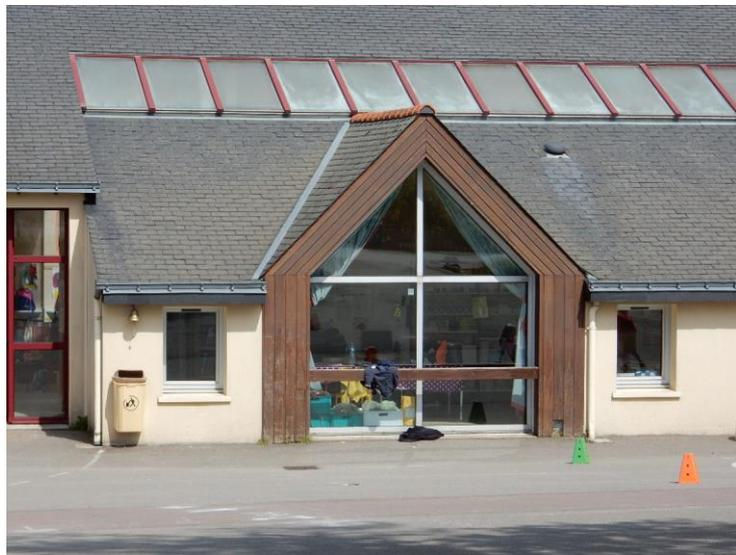
Avant: grandes surfaces vitrées et déperditives – pas de ventilation dans les classes (mauvaise QAI)
