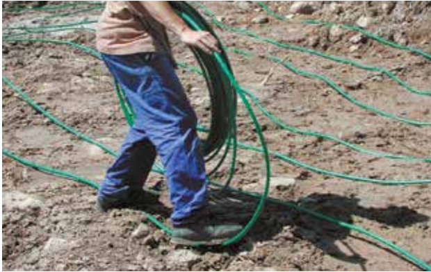
Pose de capteurs horizontaux.
