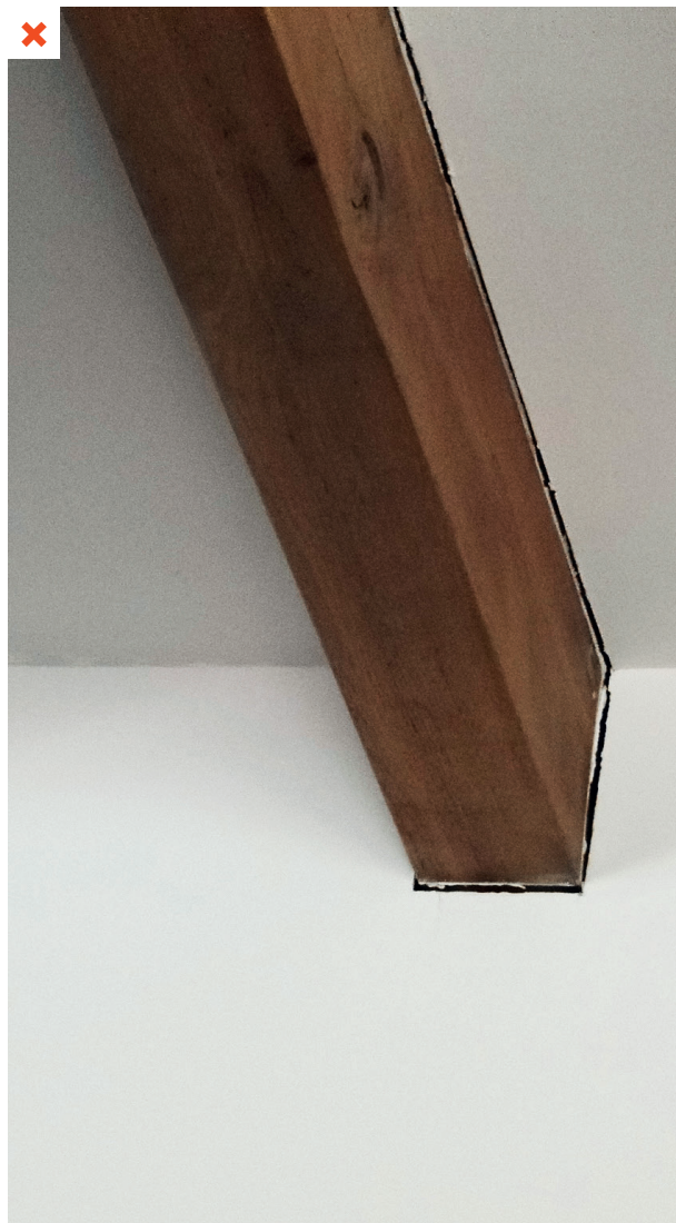
Exemple d'une poutre mise en œuvre avec un taux d'humidité excessif. Elle a subi par la suite un retrait important. ©AQC
