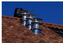
Les grilles en sous-face des cheminées permettent de récupérer les quelques gouttes d'eau dues à la condensation ou à la pluie battante en cas de tempête exceptionnelle.
