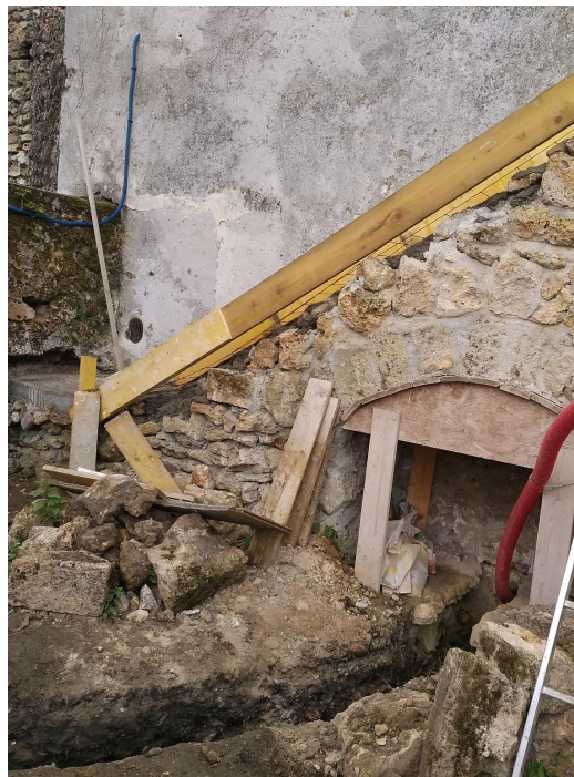
Destruction et reconstruction de l'escalier avec les mêmes pierres
