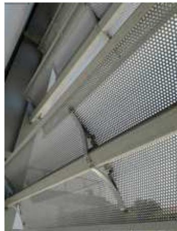
Figure 15 : Protection solaire par volets perforés [Luca Evangelisti & al.]
