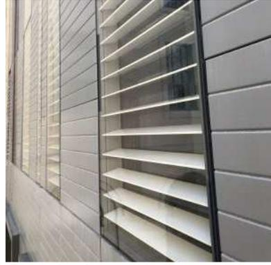
Figure 12 : Brise soleil fixe inséré au vitrage
