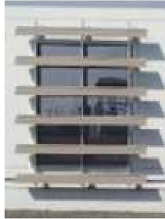
Figure 18 : Protections fixes à lames horizontales
