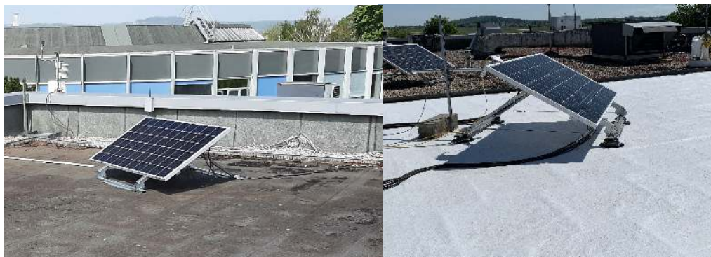
Bitume puis coolroof (>12 mai 2022)
