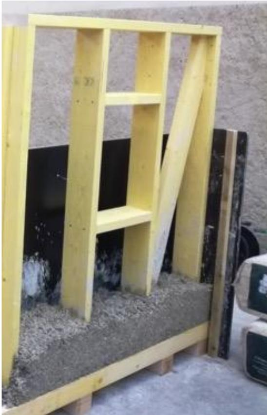
Mode constructif utilisé principalement dans le cas d'une mise en œuvre manuelle
