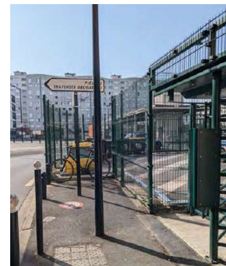
NPNRU Bois l'Abbé, Champigny-sur-Marne. Interruption du trottoir pour la cour du commissariat et encombrement par le mobilier avec un mat d'éclairage mal positionné.
