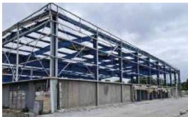
Déconstruction du parc des expositions à Toulouse (31) (© Synethic)
