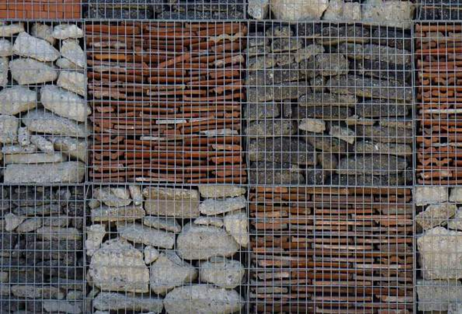
Mur d'enceinte en gabions de réemploi (gourron, concassé de béton, tuiles, briques, etc.) pour cette déchèterie à Saint-Martin d'Hères (Grenoble Alpes Métropole, © NA architecture)
