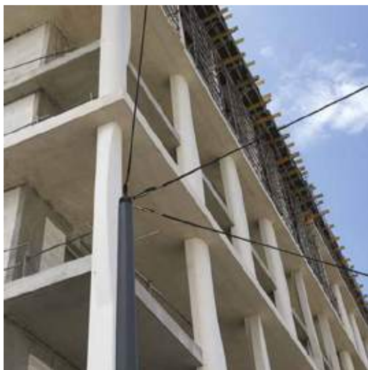
Ydeal à Lyon Confluence (69), bâtiment de bureau conçu pour être réversible (OGIC, SPL Lyon Confluence, Clément Vergély Architectes)
