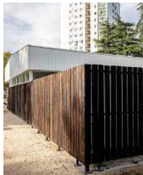
Bois brûlé à base de lames de bois de réemploi pour ce centre de santé communautaire à Echirolles (38) (association Santé solidaire en chantier, © NA architecture)
