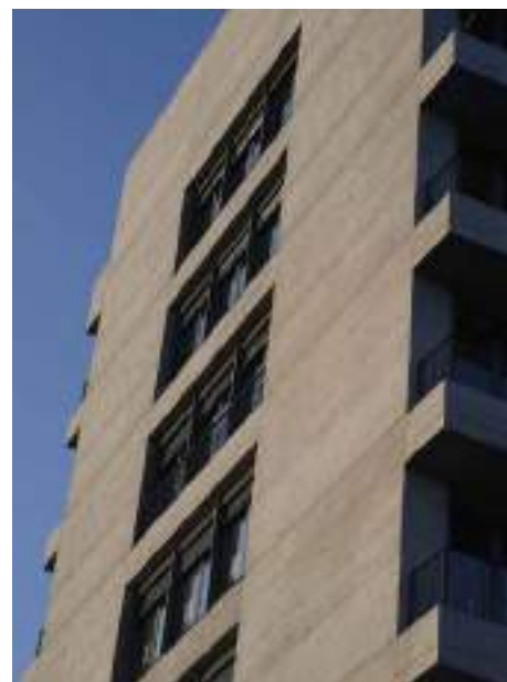
Work#1, bureaux réversibles à Lyon Confluence (69) (Linkcity Sud-Est, David Chipperfield Architects)
