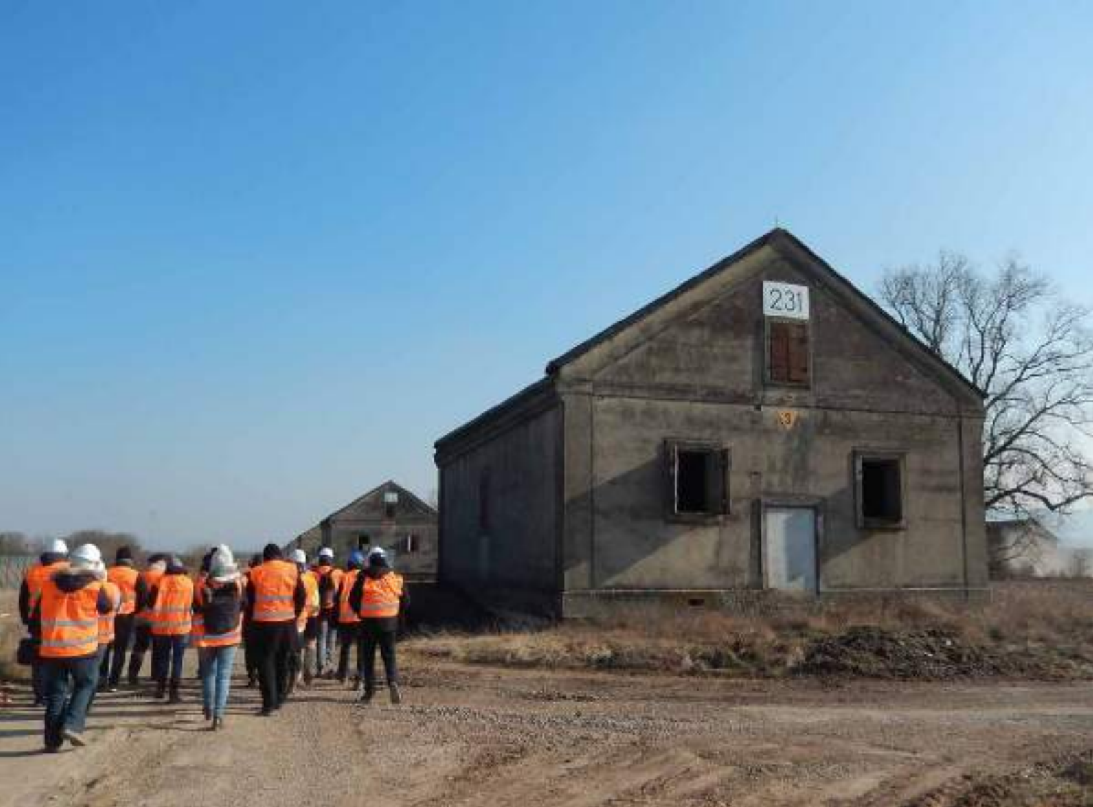
ACMUTEP, chantier de déconstruction innovant sur la plaine de l'Ain (Communauté de communes de la Plaine de l'Ain)
