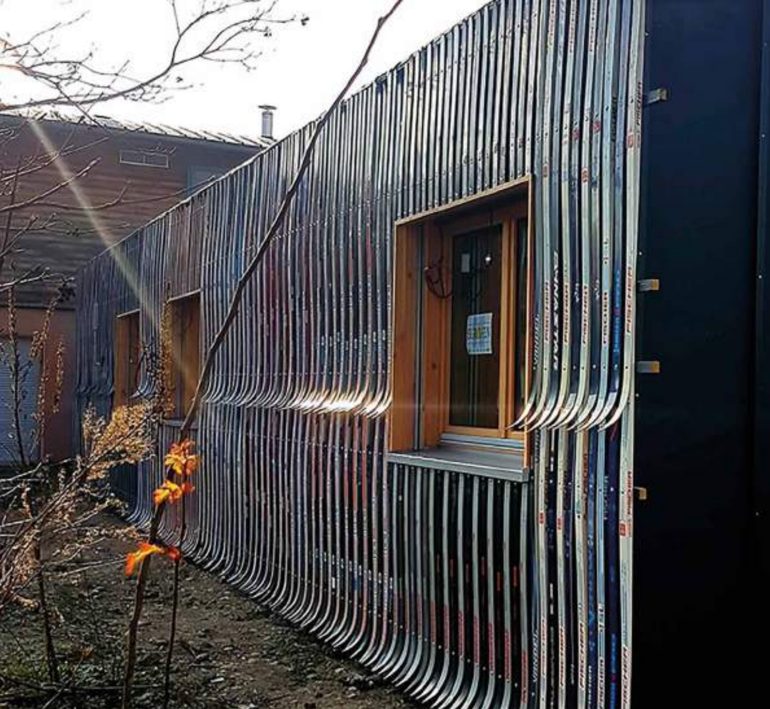
Transformation d'un bungalow vétuste en une salle de cours confortable et thermiquement performante, avec bardage en ski de réemploi (© Art Ski Tech, ASDER)
