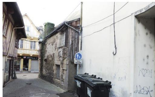
Immeuble traditionnel en R+2+comble sur plan rectangulaire (environ 12,3 x 10,5 m) implanté sur rue. La façade principale est organisée en travées tripartites avec des lucarnes en comble à l'arrière. La construction en bon état est en maçonnerie de pierre enduite aux étages avec encadrements et corniche en pierre de taille.
