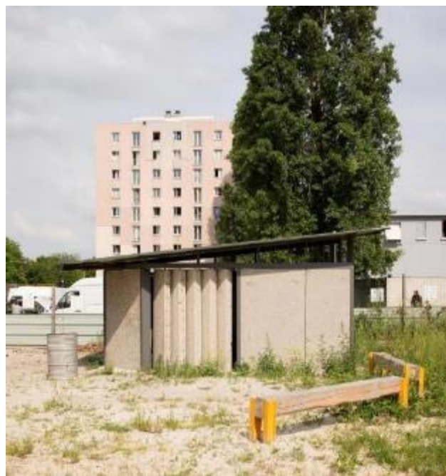
Exemple de réemploi de voiles béton (Fabrique du Clos, Stains)
