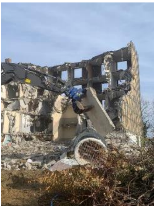
Exemple de Dépose de voiles béton (Yves Montand, Bassens)
