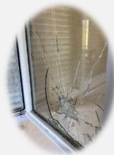
Essai destructif - vérification feuilletage
