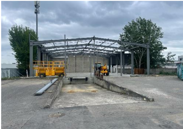
Démontage (Mediapost – Blagnac, 31)
