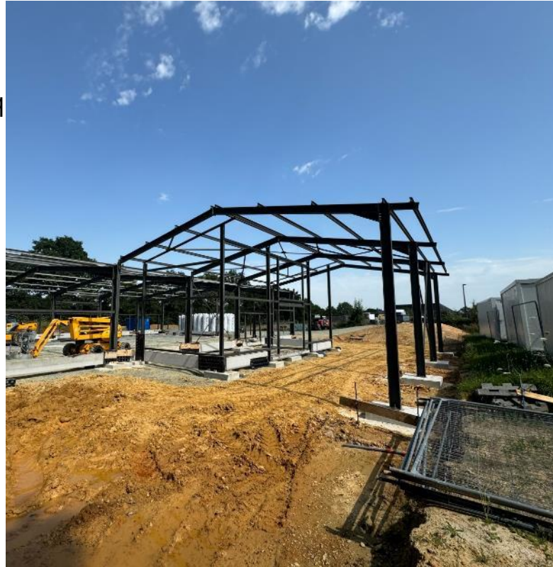
Remise en œuvre (Blain, 44)
