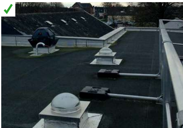
Aucun masque n'est présent à proximité des tubes de lumière naturelle et l'entretien est effectué régulièrement. ©AQC
