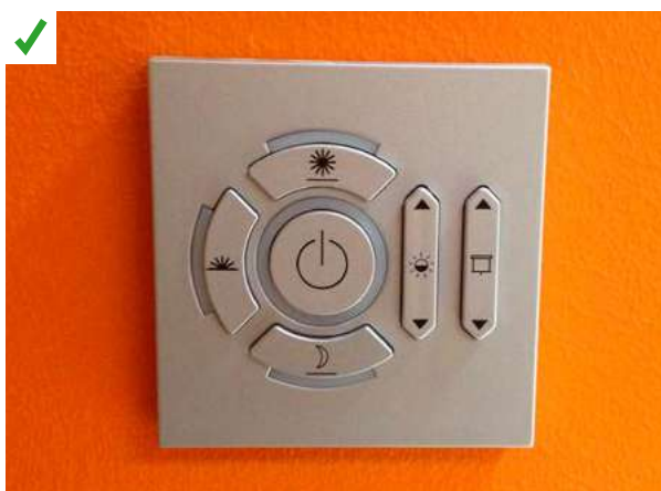
Présence d'un éclairage dynamique dans une école. La température de couleur est gérée par l'utilisateur via un interrupteur selon les moments de la journée. ©AQC
