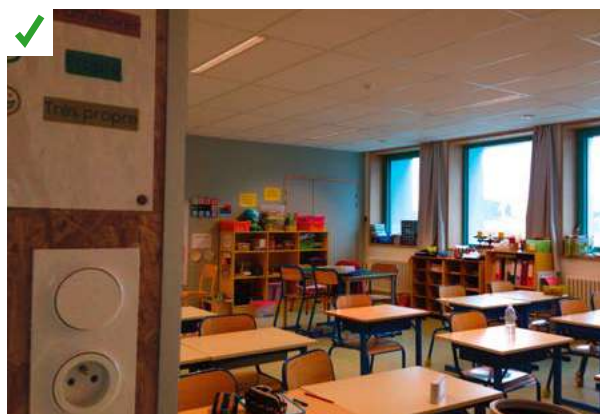
Dans cette salle de classe, le détecteur de présence est couplé à un interrupteur. Il est donc possible de forcer l'extinction des luminaires, notamment lors des projections de supports de cours. ©AQC
