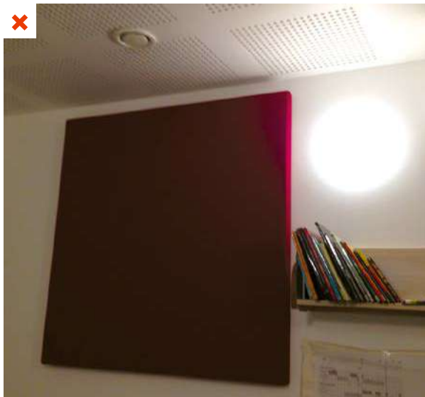
La lampe possède une température de couleur élevée (5 000 K) correspondant à un blanc froid. Ceci n'est pas adapté pour une pièce de repos. ©AQC
