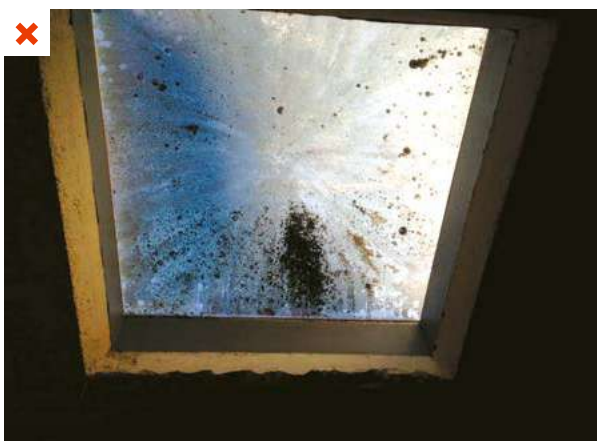
Le lanterneau est encrassé par la présence de végétation et le développement de micro-organismes. L'absence d'entretien régulier restreint l'apport de lumière naturelle. ©AQC
