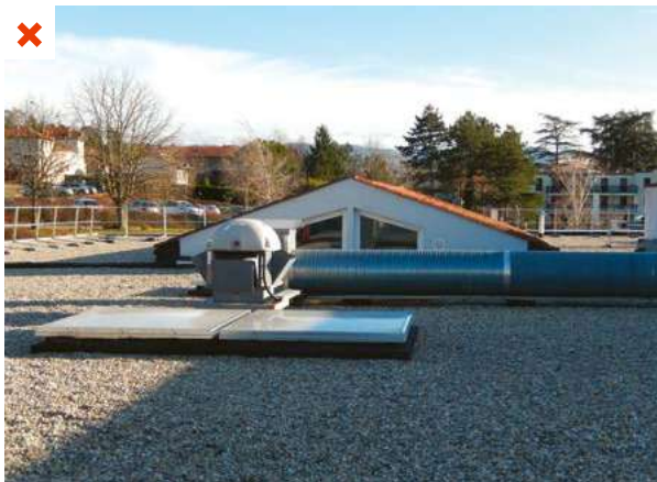
Le bâtiment voisin crée une ombre portée sur le puits de lumière. ©AQC
