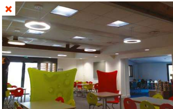
Aucun interrupteur n'est présent. Les luminaires sont directement éteints sur le tableau électrique lorsque le détecteur est défaillant, comme c'est le cas sur cette photo. ©AQC
