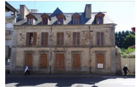
Bâtiment A Une grande bâtisse sur rue
