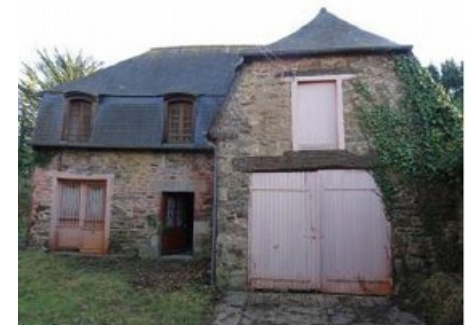
Bâtiment B Une annexe garage – ouverte coté nord
