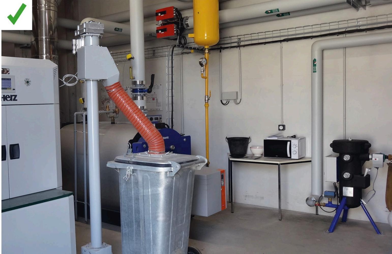
Un poste de contrôle d'humidité des plaquettes a été installé dans le local chaufferie.
