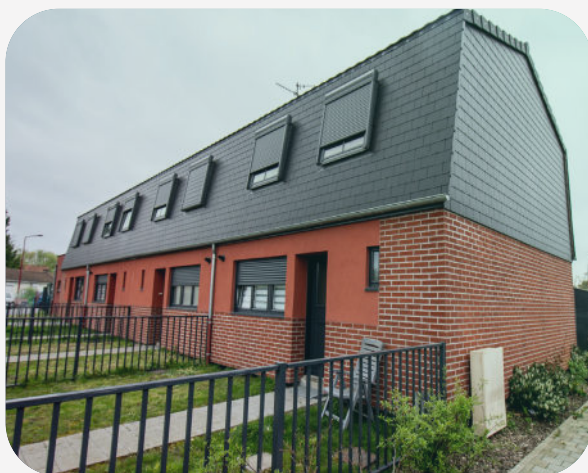
SIGH-rénovation 40 maisons-2019 maîtrise d'œuvre NORTEC ©edwood
