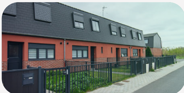
SIGH-rénovation 40 maisons-2019 maîtrise d'œuvre NORTEC- ©edwood
