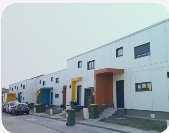
ICF Habitat Nord Est-Rénovation EnergieSprong 12 logements maisons individuelles Longueau-2018-ALTEREA Bouygues Delkia AMBois Studio Ranson Bernier © ALTYN
