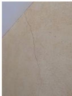
Microfissuration d'un enduit.
