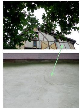
Surélévation d'un pavillon de banlieue parisienne. Fissure d'un enduit.
