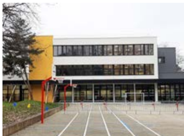
Le groupe scolaire rénové
