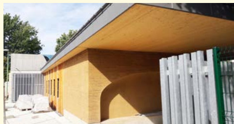
Pisé, pierre et bois, restaurant scolaire à Bourgoin Jallieu (38), OnSITE Architecture.
