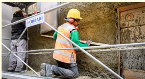
Ouvrier sur un chantier de projection de béton de chanvre.
