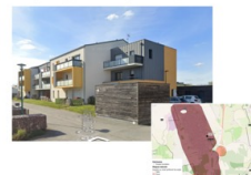
« Lot Mouton Blanc » à Pont-Péan (35) : résidence construite en 2012 et exposée à un risque « fort » de crues gonflées des sols.
