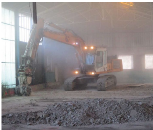
Fraisage des surfaces impactées
