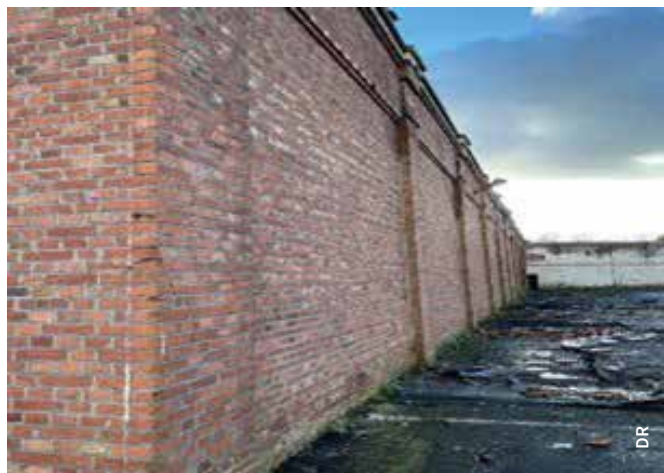
Photo n°1 : Aspect-type des murs à déconstruire.
