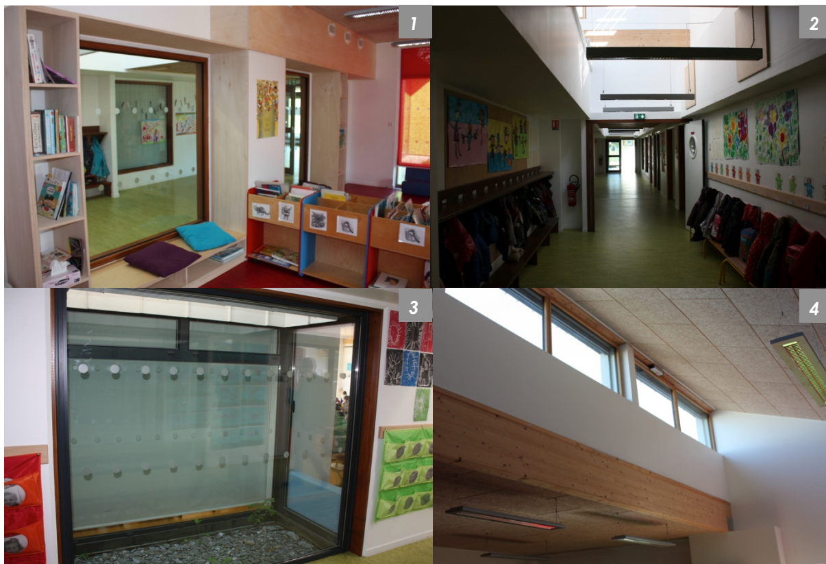
Solutions d'apport de lumière naturelle © Réseau Breton Bâtiment Durable 1 – grande vitre entre le couloir et les salles de classe 2 – Verrière photovoltaïque laissant entrer la lumière dans les espaces de circulation 3 – Puits de lumière dans les espaces de circulation 4 - Impostes vitrées au nord
