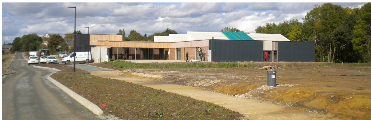
Vue sud de l'école maternelle en cours de chantier © DDTM
