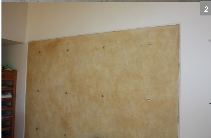
Mur en briques de terre crue (1 - en cours de chantier et 2 - avec enduit de finition © DDTM)
