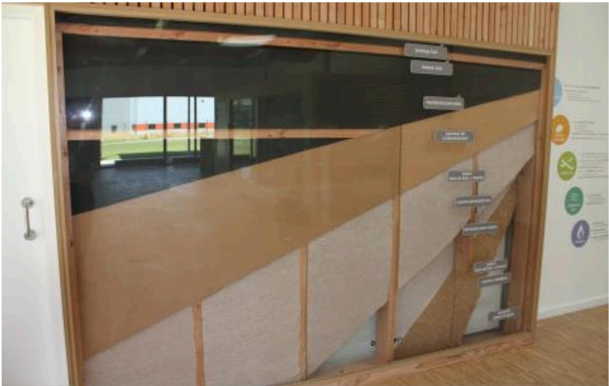
Coupe détaillant la composition des parois extérieures - © Réseau Breton Bâtiment Durable
