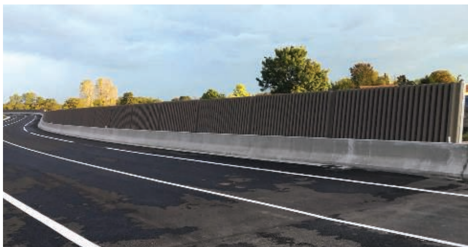
Écran béton de bois – Desserte parc industriel Saoneor — Fragnes et Champforgeuil (71)
