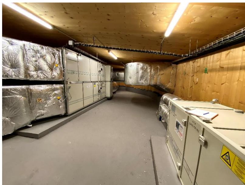
Figure : Local des CTA au 2ème étage du groupe scolaire. A gauche: CTA principale, à droite: CTA secondaire. Source: photo Cerema
