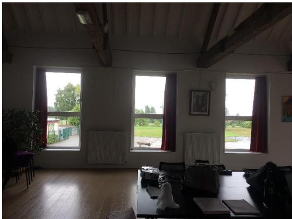
Fenêtres en bois double-vitrage, sol parqueté et plafond en tôles aluminium isolées en sous-face + poutres en bois apparentes
