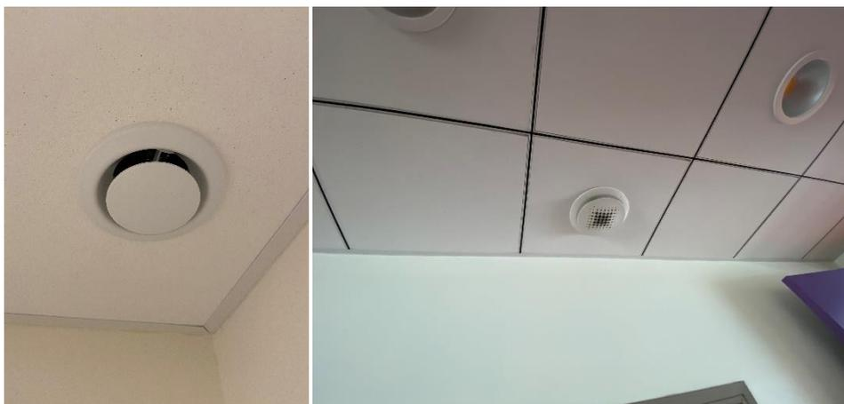
Figure : CTA secondaire: à gauche bouche d'extraction et à droite bouche de soufflage. Source: photo Cerema
