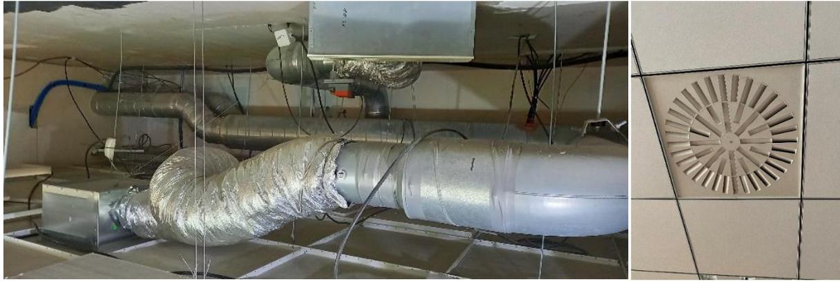
Figure : CTA principal: à gauche réseau de gaines et grille de reprise d'air vicié, à droite bouche de soufflage dans une salle de classe. Source: photo Cerema
