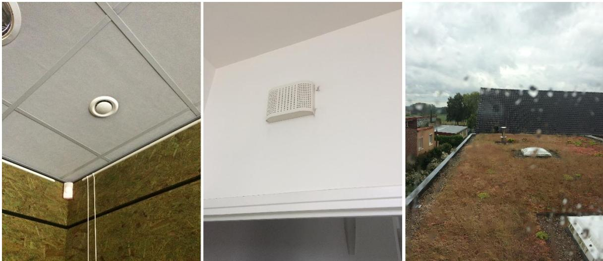
Figure : Illustration des bouches de ventilation en rez-de-chaussée (gauche) et à l'étage (milieu) et de la prise d'air neuf sur le toit (droite). Source : photo du Cerema
