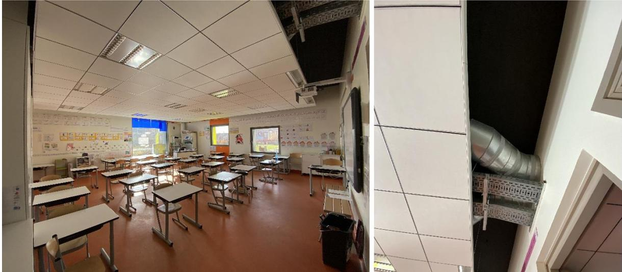
Figure : Salle de classe 8 avec ses murs peints en blanc, son sol recouvert de revêtement plastifié et le faux-plafonds désolidarisé des parois verticales (zoom à droite et vue sur la dalle et les gaines). Source : photos du Cerema
