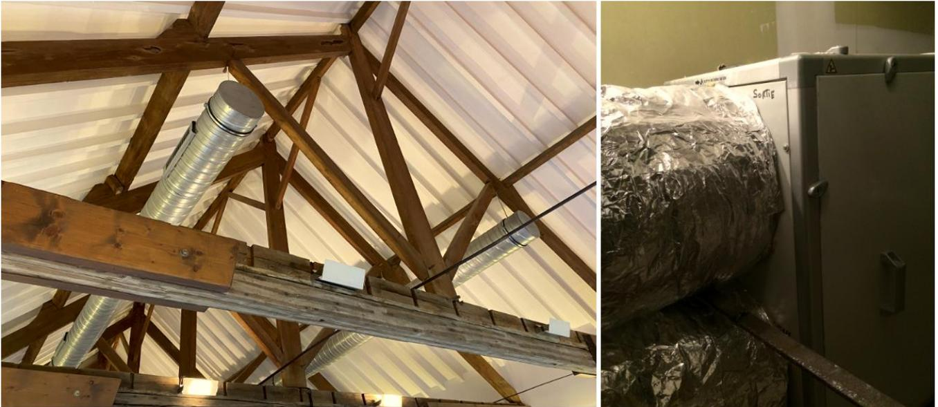
Figure : A gauche : réseau des gaines de ventilation de la salle des mariages. A droite: CTA avec gaines isolées. Site n°1 – mairie de Moncheaux. Source: Cerema
