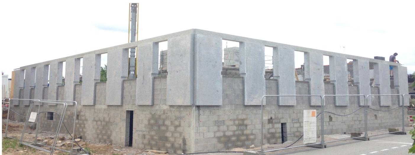
Chaînage en béton sablé des trente-deux blocs de granit © photo - Pascal Leopold
