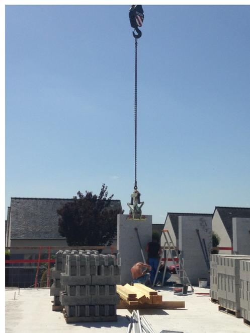
Mise en place des blocs par une pince de levage © photo - Pascal Leopold
