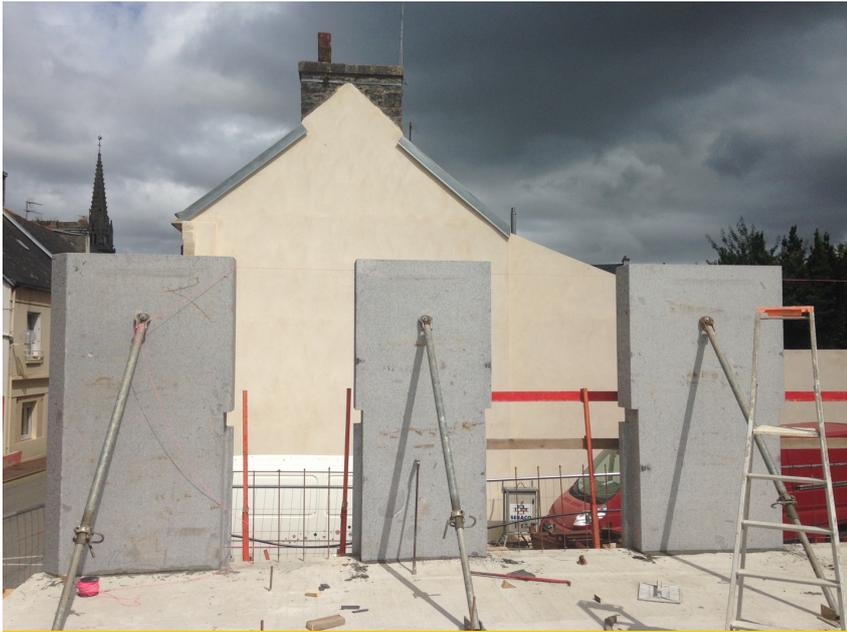
Ajustement de l'aplomb grâce à des étais fixés sur le bloc et au sol
