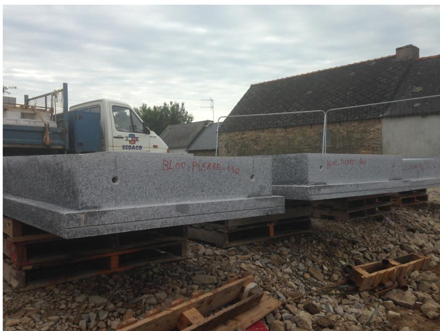
Livraison des blocs prédécoupés, prépercés pour l'emplacement des goujons et rainurés pour la goutte d'eau © photo - Pascal Leopold
