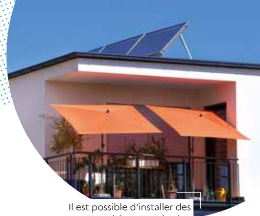
Il est possible d'installer des panneaux solaires sur toit plat, en respectant une inclinaison comprise entre 30 et 60°.
