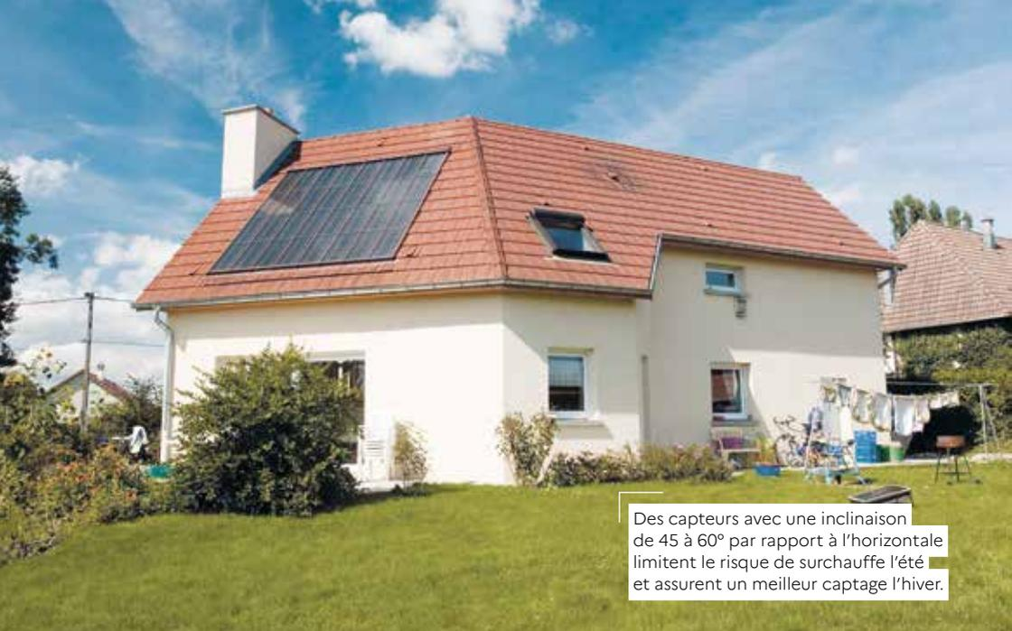
Des capteurs avec une inclinaison de 45 à 60° par rapport à l'horizontale limitent le risque de surchauffe l'été et assurent un meilleur captage l'hiver.
