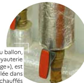
L'isolation du ballon, comme de la tuyauterie (« calorifugeage »), est vivement conseillée dans les locaux non chauffés (cave, garage).
