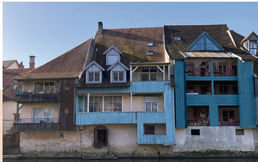
Diversité des balcons en Bourgogne-Franche-Comté Ci-dessous (de haut en bas) Vue depuis la Loue à Ornans (39) et rue Monge à Dijon (25) – © Ajena
