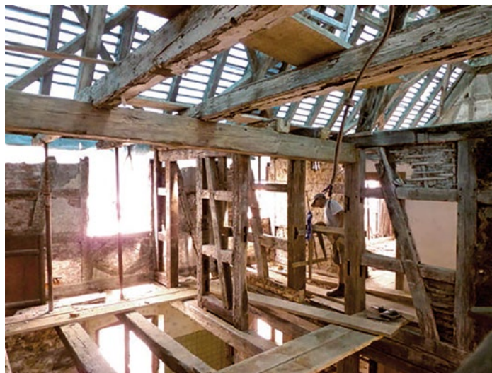
Le plancher du premier étage a été déposé pour permettre une projection continue du béton de chanvre entre les étages – Schnersheim (67) – © CREBA
