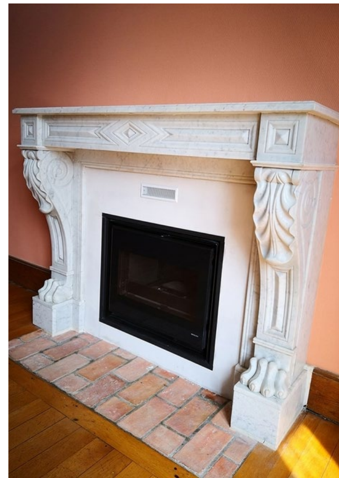
Insert dans une cheminée existante © Entreprise Goupil
