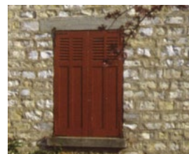
Mur maçonné en pierre meulière
