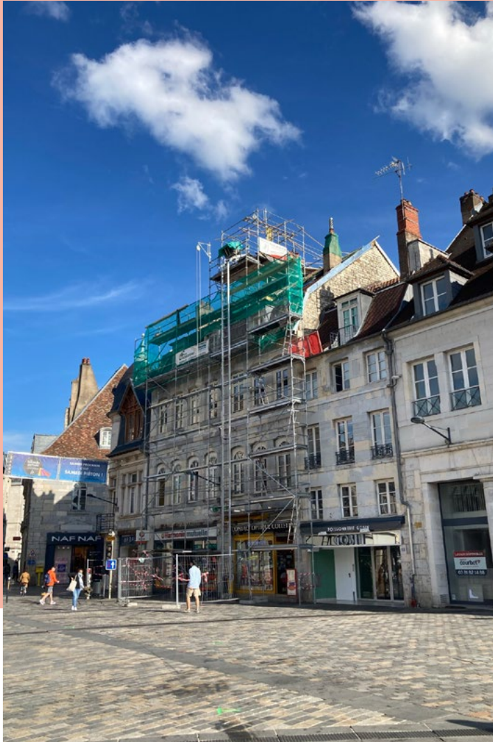
Immeuble en travaux, place de la Révolution à Besançon (25) – © Ajena
