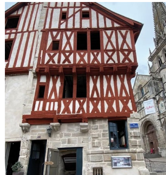
Rénovation d'un immeuble à Autun (71) qui a pu retrouver son pan de bois – © Epur'Archi
