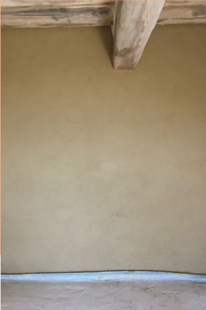
Enduit terre sur un mur ancien à Merry-la-vallée (89) – © Pascal Fortunier – CREBA
