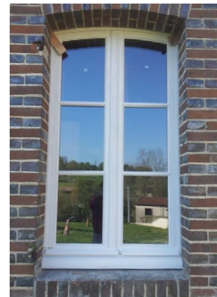
Pose de nouvelles menuiseries en bois avec double vitrage (89) © Pascal Fortunier – CREBA
