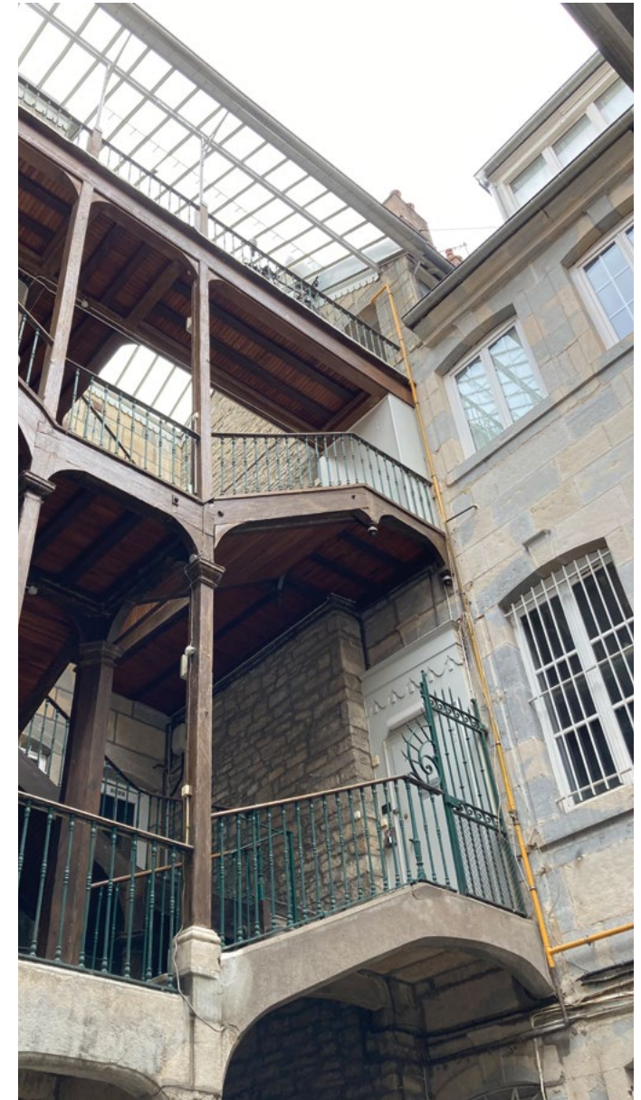
Cage d'escalier dans une cour intérieure à Besançon (25) © Stéphanie Honnert Architecte
