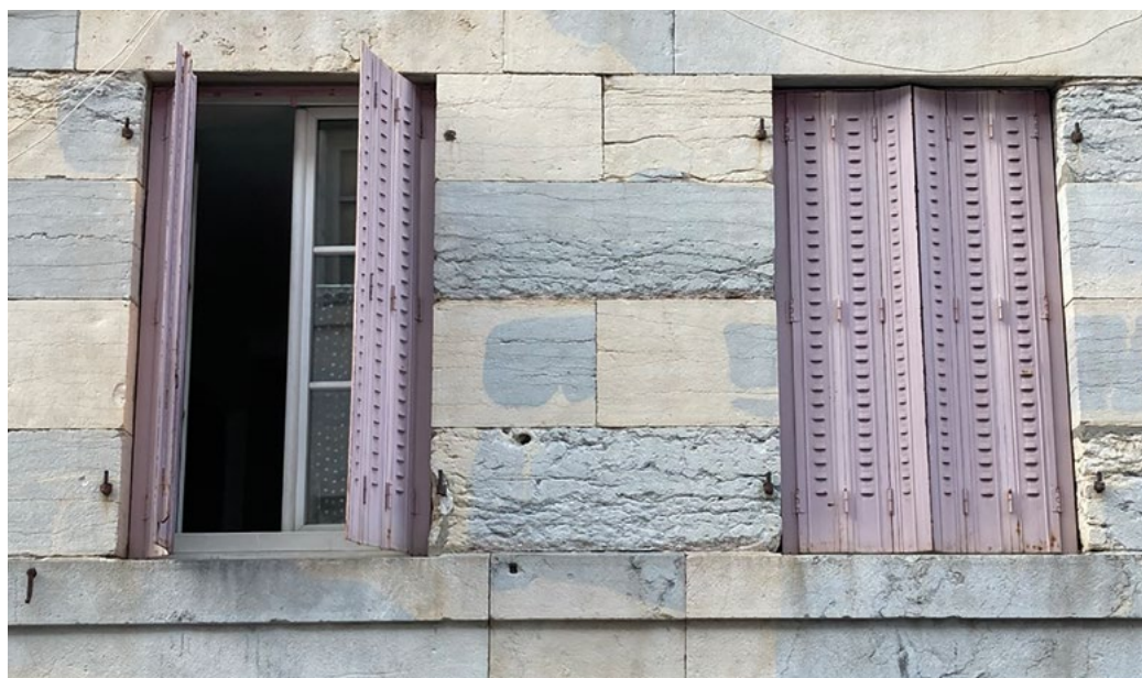
Persiennes métalliques – rue Grand-Charmont à Besançon (25) – © Ajena
