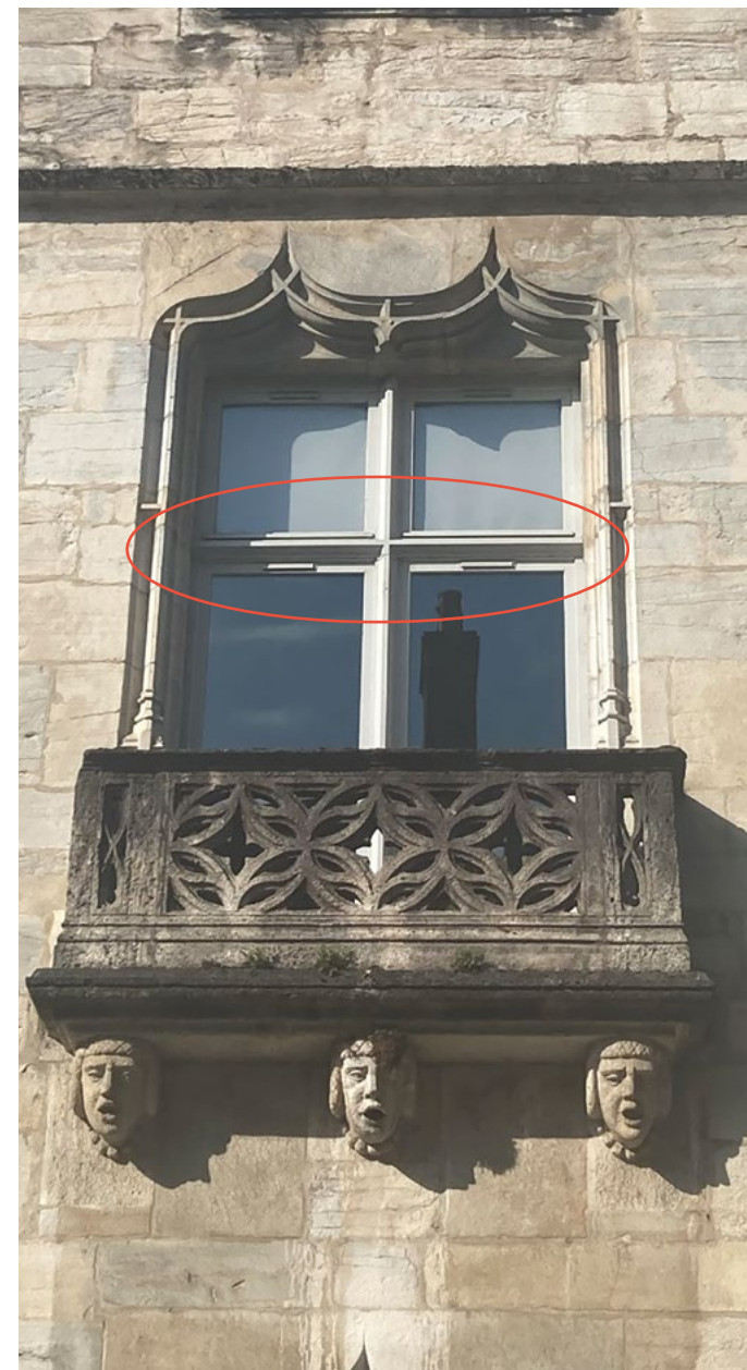
Baie médiévale du XV e siècle On remarquera la présence discrète de grilles de ventilation Rue Grand-Charmont à Besançon (25) © Ajena
