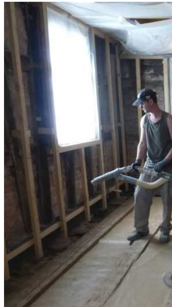
Application de ouate de cellulose projetée. Immeuble à pan de bois à Schnersheim (67) © Denis Elbel – CREBA
