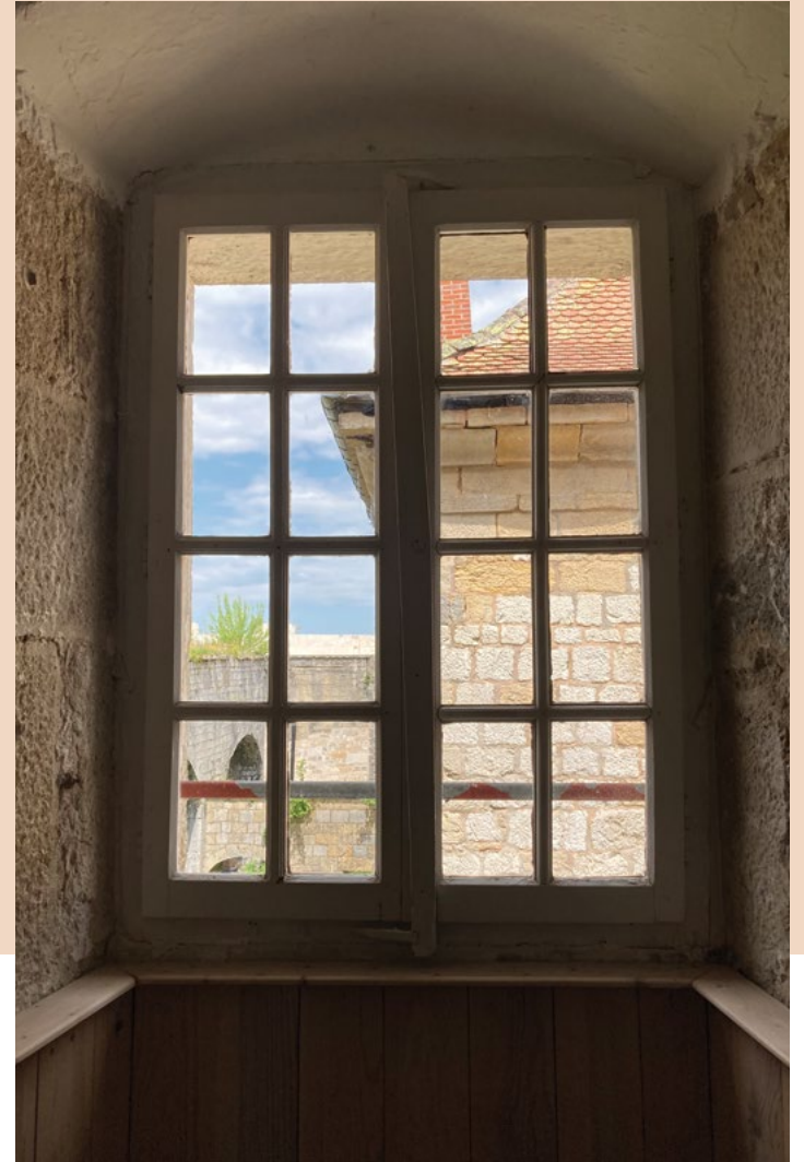
Baie classique du XVIII e siècle à Besançon (25) © Stéphanie Honnert Architecte
