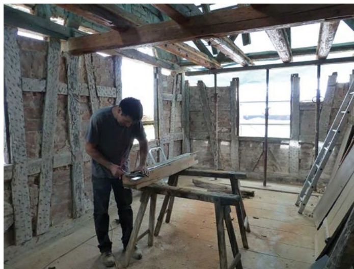
Réalisation de tenons et mortaises pour le pan de bois – Schnersheim (67) – © CREBA
