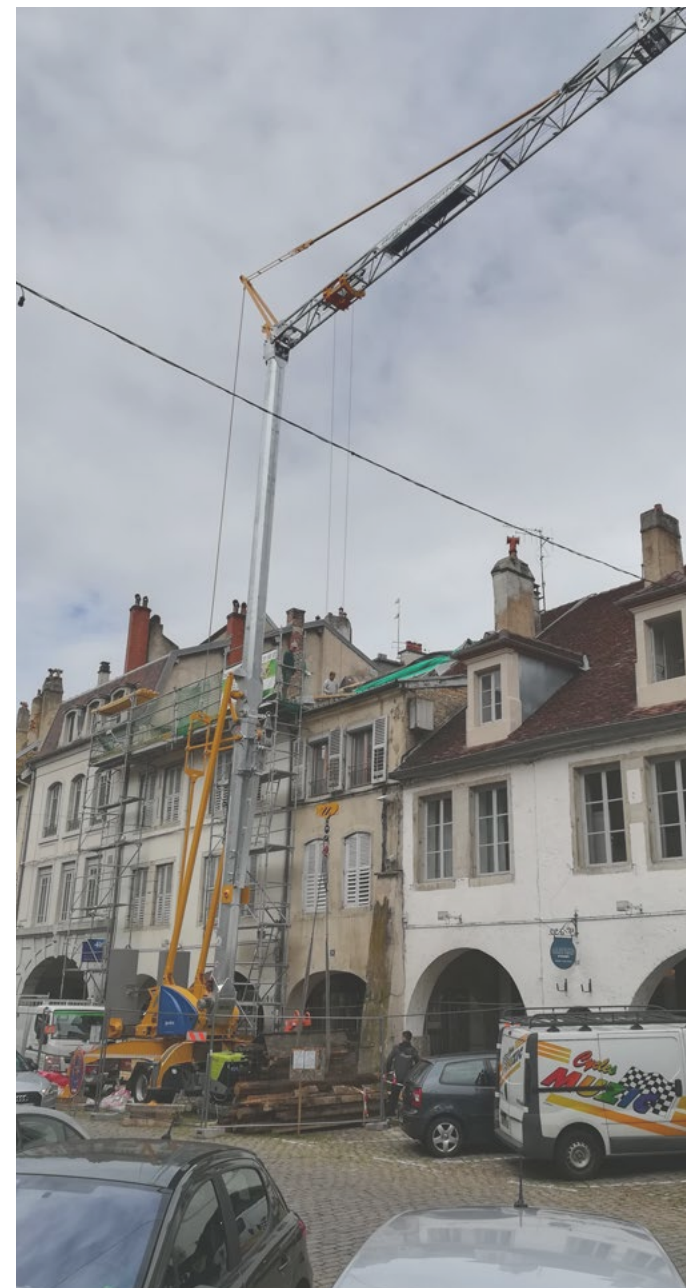
Exemple d'occupation de voirie pour des travaux de couverture à Lons-le-Saunier (39) – © Ajena
