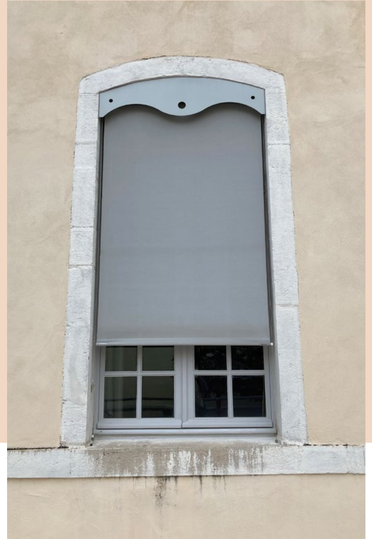
Pose d'un store dans le centre-ville de Lons-le-Saunier (39) – © Ajena
