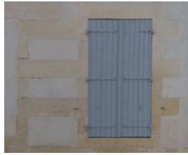
Encadrement de baies en pierre de taille
