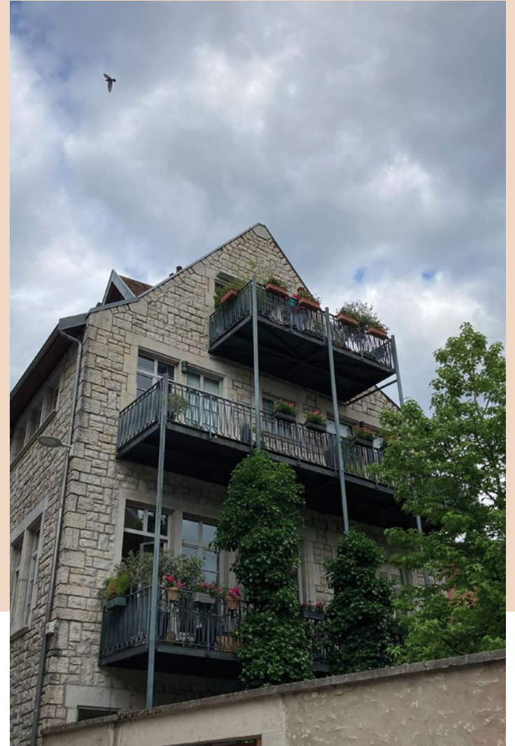
Balcon végétalisé, rue d'Anvers à Besançon (25) © Ajena
