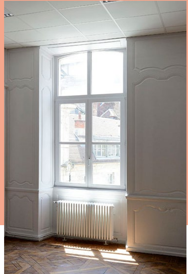
Radiateurs intégrés – 6, rue de la Madeleine à Besançon (25) © Nicolas Waltefaugle Architectes : Lefranc-Corbet-Friant et Tempesta
