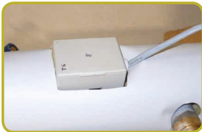
Sonde prévue pour un montage en applique, calorifuge reposé
