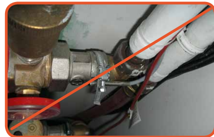
Sonde à plongeur, pas adaptée à un montage en applique ; pas de pâte thermique ni de calorifuge
