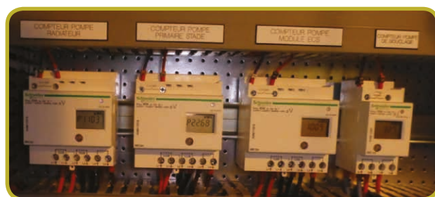
Compteurs électriques sur rails DIN, explicitement libellés
