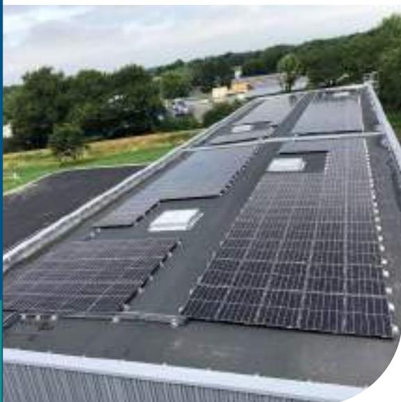
Image : centrale réalisée en technique courante par le groupe IEL sur le toit de Radian (Bouaye - 44) avec le système de fixation Roof-Solar Bitume de Dome Solar.
