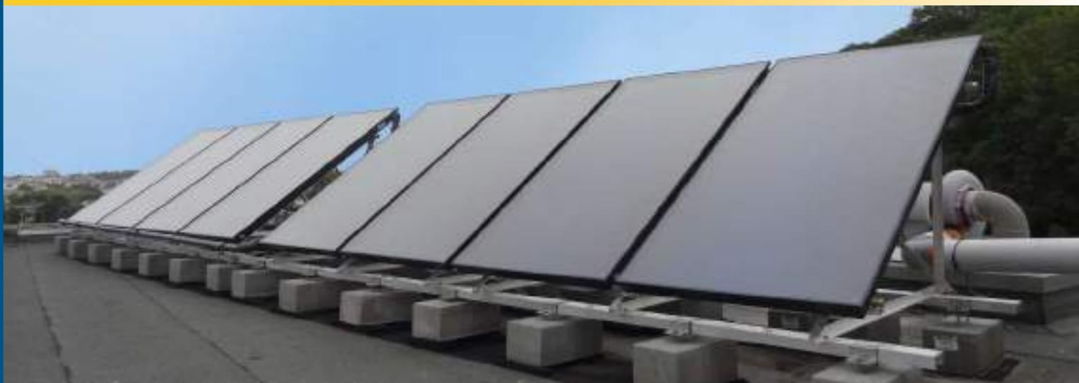
*Le solaire thermique exploite la propriété naturelle des couleurs sombres à absorber le rayonnement du soleil. L'énergie solaire thermique provient de la conversion du rayonnement transmis par le soleil en chaleur. Cette chaleur peut être utilisée directement pour la production d'eau chaude sanitaire, de chauffage et de climatisation, ou indirectement pour obtenir de l'énergie électrique ou pour la production de froid.*
