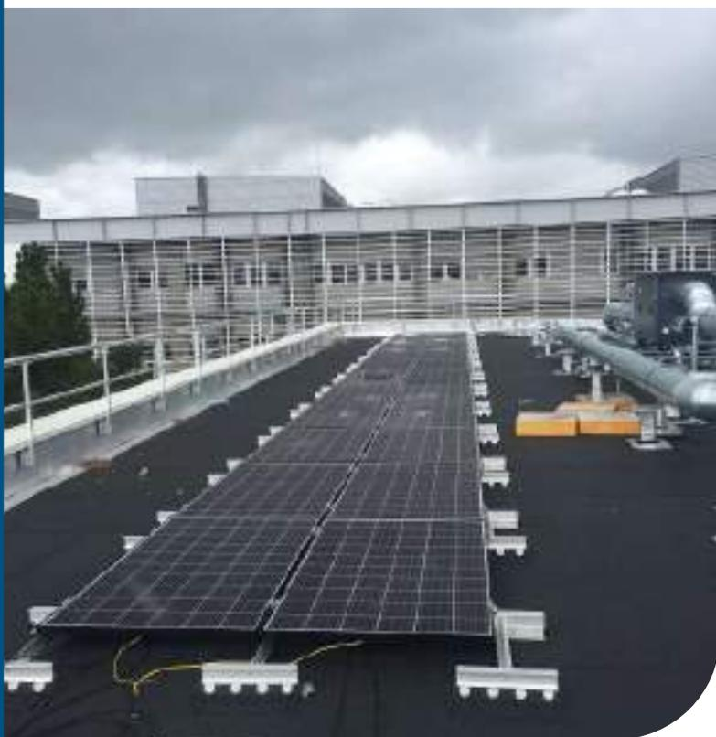
Image : centrale en toiture réalisée en technique courante par JCM Solar
