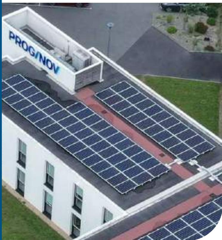
Image : centrale réalisée en technique courante par EDF EnR sur le toit de Proginov (La Chevrolière - 44) avec le système de fixation Roof-Solar Bitume de Dome Solar.
