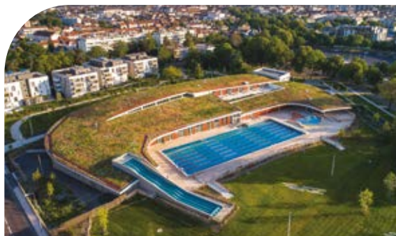
Piscine du Carrousel à Dijon (réalisée en 2019)
