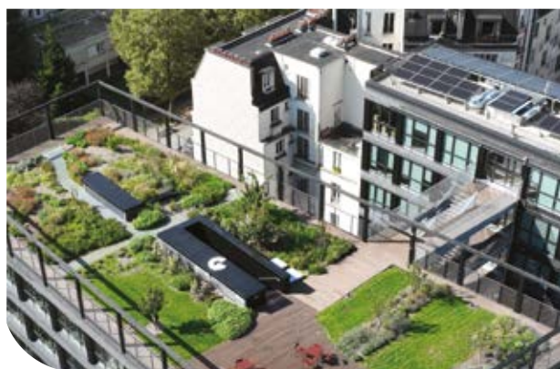
Wood-E à Pantin (réalisée en 2023)
