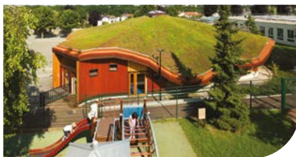
Restaurant scolaire à Noisiel (réalisé en 2013)
