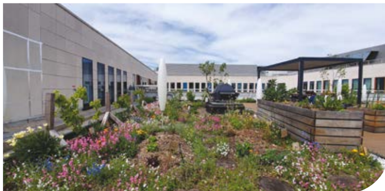
Site RATP de Bal Bienvenue à Fontenay-sous-Bois (réalisé en 2021)
