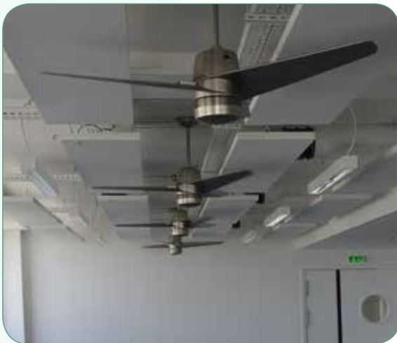
Immeuble Mediacom à Saint-Denis © TRIBU
