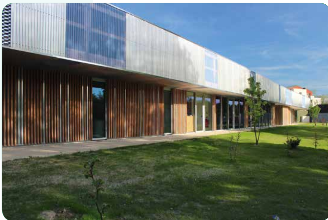
Façade Nord-Ouest © Colomes Nomdedeu
