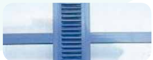
Figure 18 : Grille verticale intégrée dans la menuiserie. Source : energieplus-lesite.be
