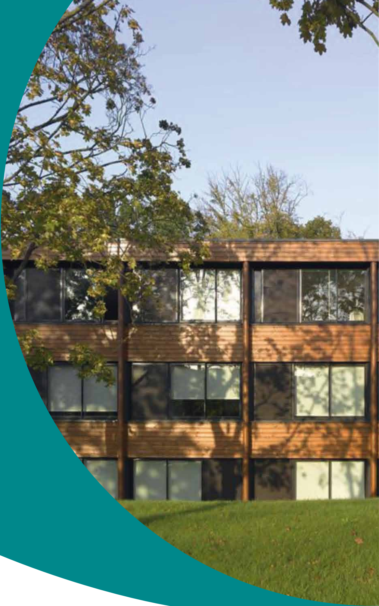
Bureaux du pôle accueil-formation de l'INERIS (architecte : cabinet ARVAL)
