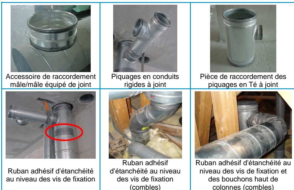
Planche 3–5 : Composants du réseau N°1 et assemblage
