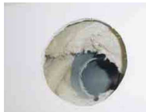
Fuite légère en tête de colonne : bouchon imparfaitement étanche
