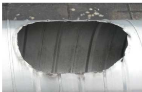
Figure 57 : Découpe de la trappe de visite sur un conduit spiralé (à gauche) et non spiralé (à droite).
