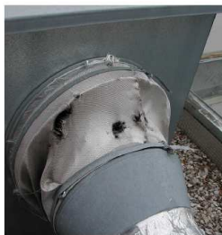
Figure 48 : Exemples de raccordements entre le caisson d'extraction et le conduit aérial. Apparence correcte à gauche ; manchette fissurée raccordant deux sections différentes à droite (solution à proscrire)
