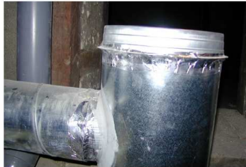
Figure 52 : Fermeture d'un té-souche avec rivets et ruban adhésif
