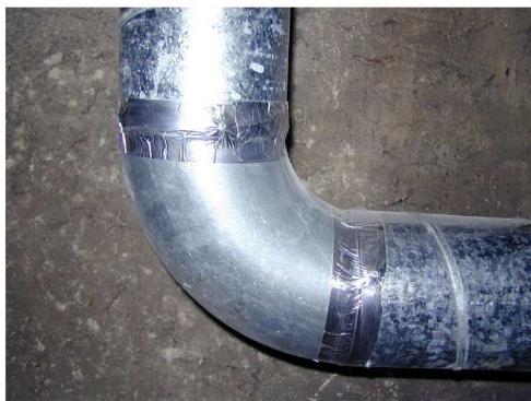
Figure 44 : Utilisation d'une pièce préfabriquée pour le raccord entre deux conduits (mise en place de mastic, rivets et bande adhésive)
