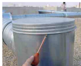
Fuite légère en tête de colonne : bouchon imparfaitement étanche
