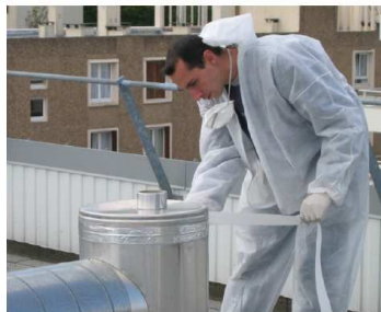
Figure 52 : Fermeture d'un té-souche avec rivets et ruban adhésif
