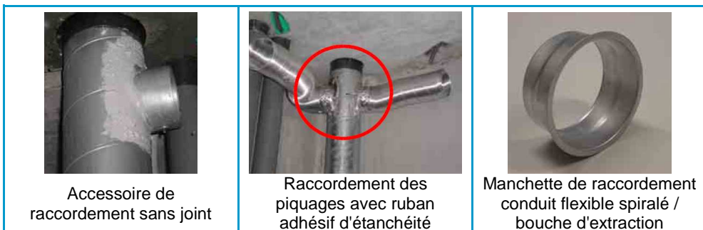
Planche 3–6 : Composants du réseau N°2 et assemblage
