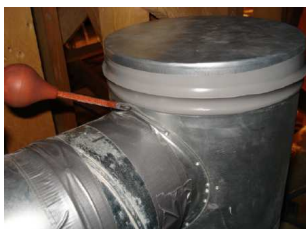
Défaut d'étanchéité au niveau du piquage sur Té-souche
