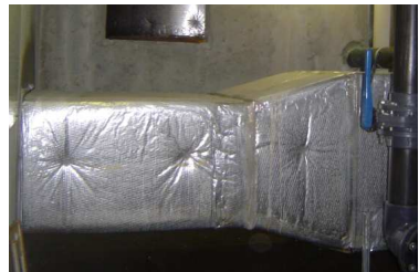
Isolation rapportée sur un réseau rectangulaire
