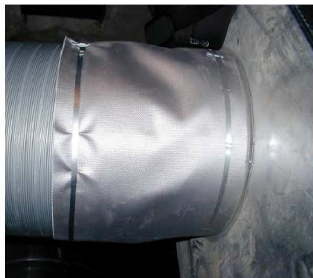
Figure 48 : Exemples de raccordements entre le caisson d'extraction et le conduit aérial. Apparence correcte à gauche ; manchette fissurée raccordant deux sections différentes à droite (solution à proscrire)
