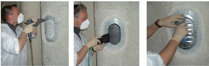
Figure 55 : Pose d'une trappe de visite
