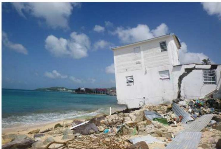
*Figure 49: Basculement d'une habitation dans le vide à Sandy Ground (Saint-Martin) (Source : BRGM, Impacts du cyclone IRMA sur le littoral des « Illes du Nord » à Saint-Martin et Saint-Barthélemy, octobre 2017)*
