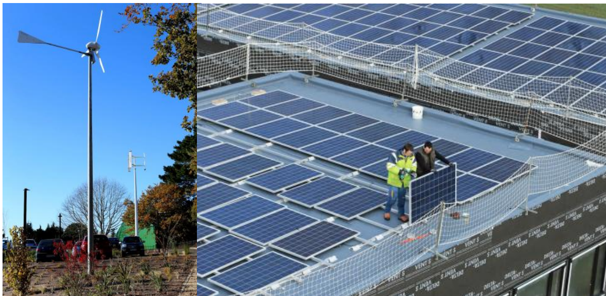
Production d'énergie électrique par 850 m 2 de panneaux photovoltaïques et 2 petites éoliennes - photo © sdem
