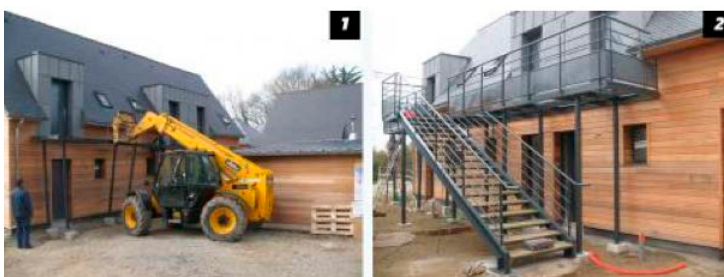
Pose de l'escalier autoportant / © Réseau Breton Bâtiment Durable
