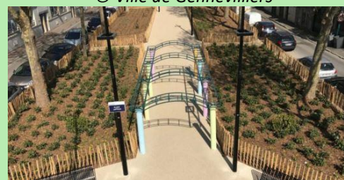
Place Jaffeux après travaux © Métropole Grand Paris
