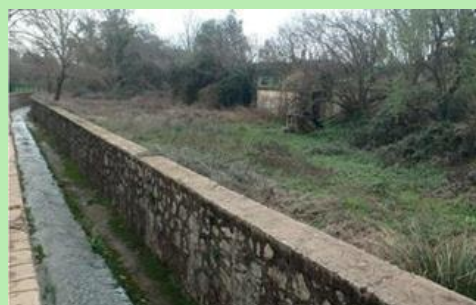
Cours d'eau canalisé avant restauration © RRGMA-PACA
