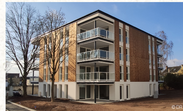
Résidence Soleil, logements Freyming-Merlebach (57), 2021 Architectes : Espace Architecture BET : EFFI MAIT
