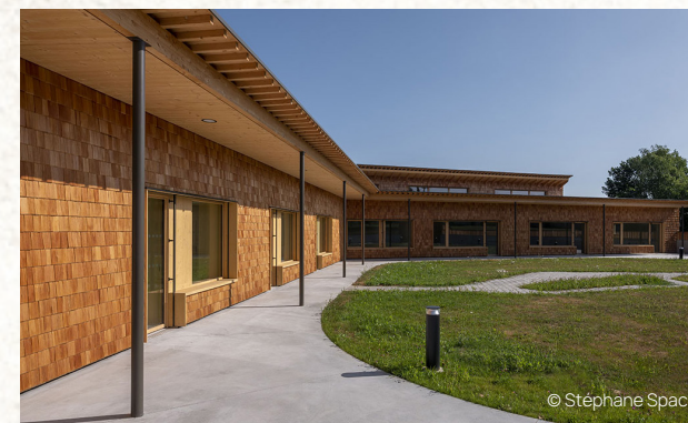
Plateforme handicap mutualisée Diemeringen (67), 2019 Architectes : Ajeance BET : Terranergie
