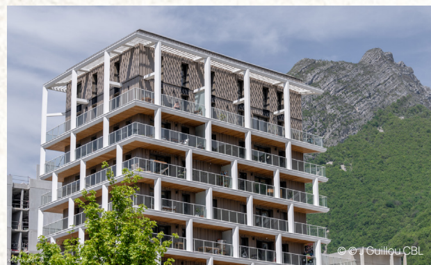
Logements et bureaux Grenoble (38), 2023 Architectes : PETITDIDIERPRIoux Architectes et A Trois BET : Solares Bauen
