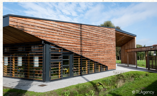
L'Abeille Gourmande, restaurant scolaire Loss (59), 2021 Architectes : Atelier d'Architecture Delsinne BET : Energelio
