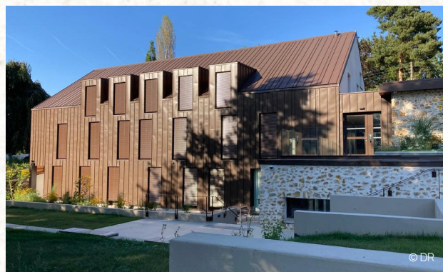
Centre d'hébergement du Parlement Européen Bazoches-sur-Guyonne (78), 2022 Architectes : M3 Architectes PH Consultant : Miguel Alberto Curtido Cutilla
