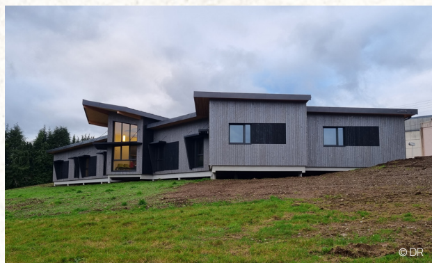
Maison de santé pluridisciplinaire Châteaulin (29), 2021 Architectes : ARKO Architectes BET : Batitherm Conseils
