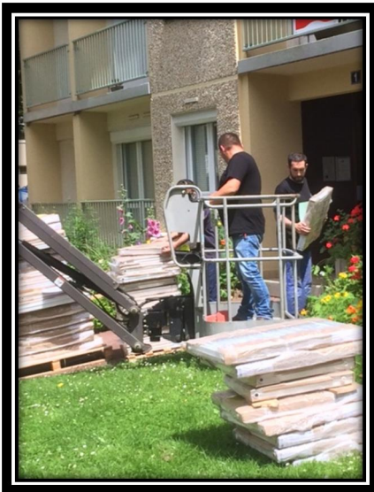
1 re Livraison des radiateurs
