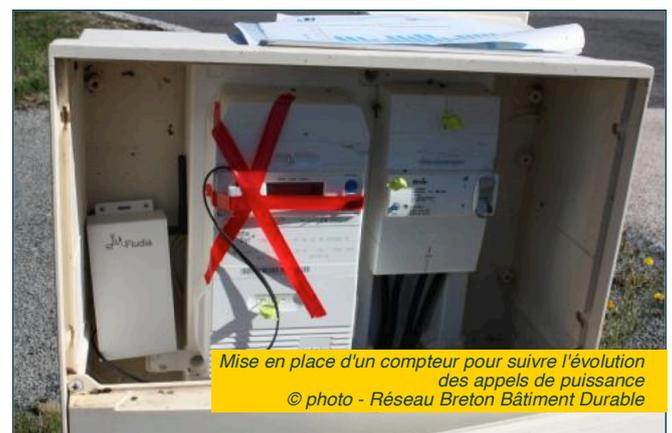
Le suivi des puissances réalisé sur le compteur général montre un seuil de 600 W en dessous duquel on ne descend jamais y compris en période d'inoccupation. En parallèle, dans le CCTP il est indiqué que la double flux a une puissance de 500 W ce qui pourrait correspondre. Ce constat a conduit à la vérification de la programmation de la double flux qui en effet n'avait pas de programme réduit d'enregistré.
