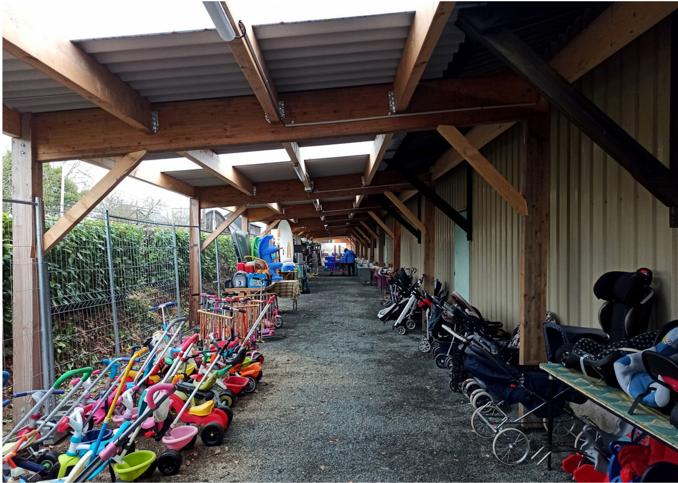
Salle de vente n°1 & aménagements extérieurs
