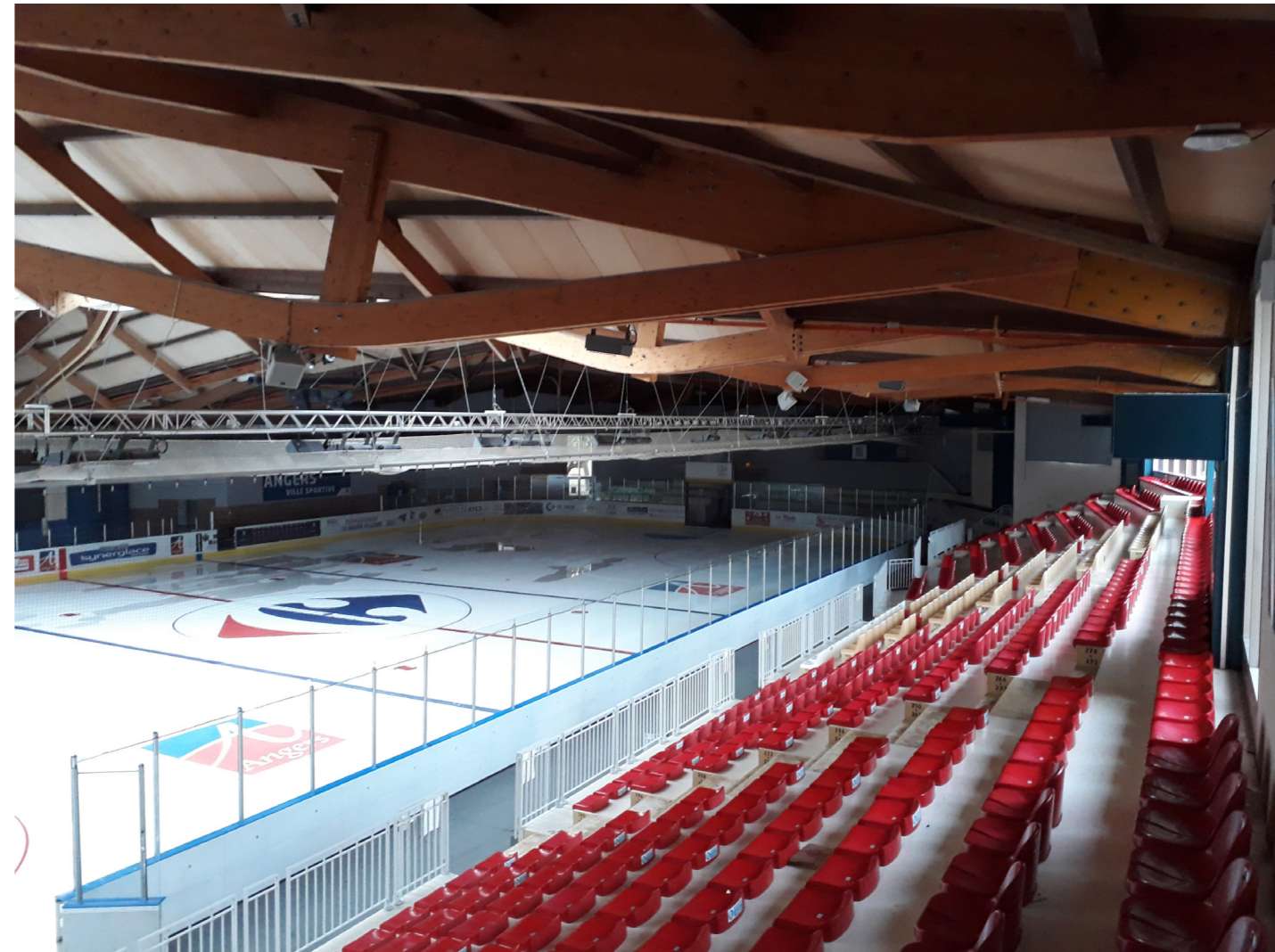
Poutres cintrées Patinoire du Haras / Ville d'Angers
