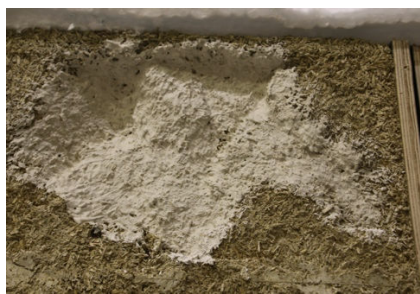
Photo 6 : béton de chanvre humidifié avec un coulis de liant de même composition que celui ayant servi à faire le béton de chanvre initialement.
