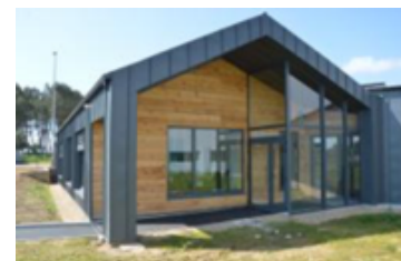
© Réseau Breton Bâtiment Durable
