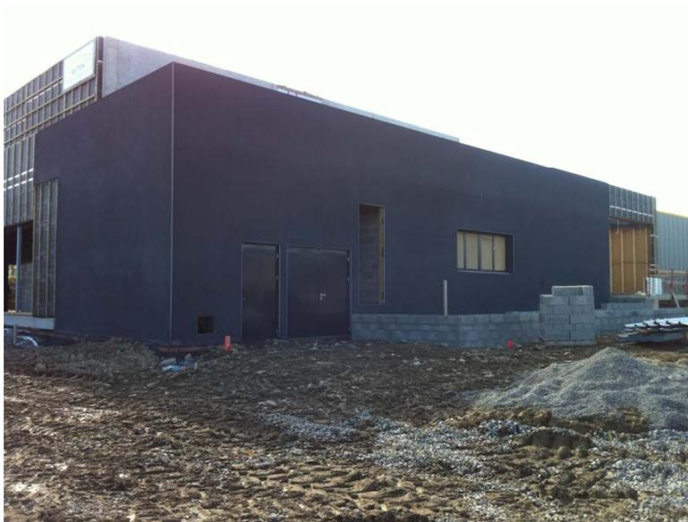
Locaux techniques, chaufferie, ventilation, rangements en parpaing pour assurer le degré coupe-feu des parois conformément à la réglementation sécurité incendie
