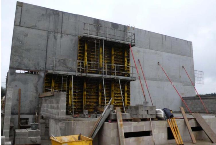
Mur du fond scène en béton banché assurant le rôle de filtre acoustique
