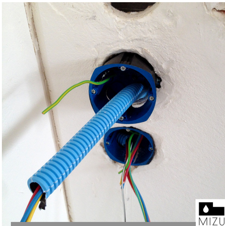
Mise en place des gaines et boîtiers blindés. © Hinoki
