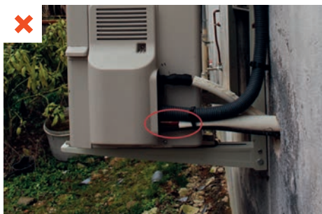
L'isolation du réseau frigorifique est incomplète. Elle s'interrompt avant d'arriver au droit de l'unité extérieure. En outre, la traversée du mur par les réseaux n'est pas étanche. ©AQC
