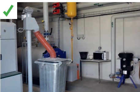
Installation d'un poste de contrôle d'humidité des plaquettes dans le local chaufferie composé d'un micro-ondes et d'une balance type pèse-lettre. ©AQC
