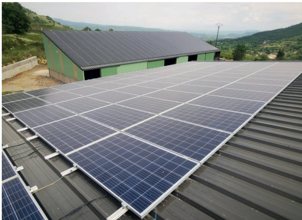
Centrale photovoltaïque posée en surimposition sur les bacs acier de toitures agricoles.
