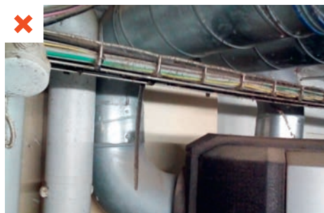
Des câbles électriques cheminent au-dessus du CET et entravent le changement du filtre qui se fait en déployant la partie haute. ©AQC
