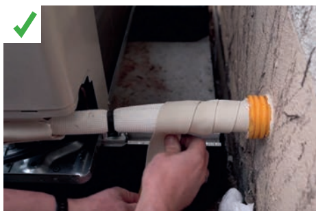
Un complément d'isolation avec un matériau adapté est appliqué sur les parties initialement non calorifugées. © AQC
