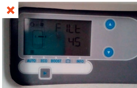
Le panneau d'affichage montre la saturation du filtre de la pompe à chaleur avec l'erreur « FILT ». Aucune intervention n'est prévue ni programmée. ©AQC
