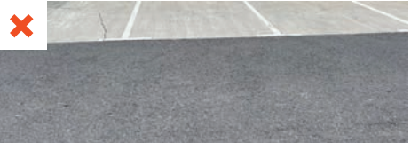
Places de parking minéralisées. ©AQC
