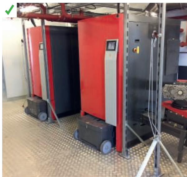
Pour la production de chauffage et d'eau chaude sanitaire de cet hôtel, une installation monoénergie a été mise en œuvre. Deux chaudières d'une puissance maximale équivalente ont été installées. Cette répartition des puissances a été dictée par la forte demande en eau chaude sanitaire tout au long de l'année.
