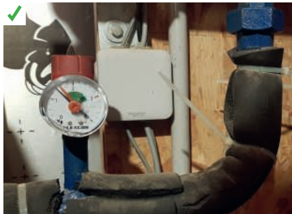
La présence d'un manomètre permet de vérifier la pression du réseau hydraulique et l'absence de fuites, notamment avant le changement de la chaudière. ©AQC
