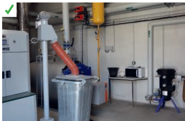
Installation d'un poste de contrôle d'humidité des plaquettes dans le local chaufferie composé d'un micro-onde et d'une balance type pèse-lettre. ©AQIC
