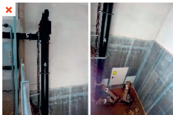
Le système d'alimentation entre le silo enterré et la chaudière est composé de 5 vis sans fin. Les deux premières (1 et 2), horizontales, permettent l'acheminement du combustible vers la chaufferie. Les trois autres (3, 4 et 5) servent à l'acheminement vers le foyer. ©AQC
